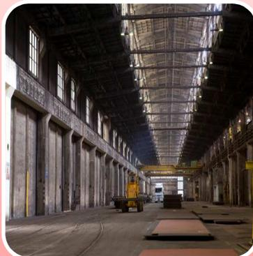
Instalada dentro de la factoría de Arcelor. Consta de una superficie abierta de 24.000 m<sup>2</sup> con unas dimensiones de 700 metros de largo y 30 metros de ancho. Está estructurada en un Parque de entrada, una zona de proceso y un Parque de salida con tres vías de ferrocarril para transporte y movimiento de chapas.
